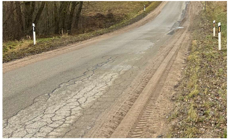
9 pav. Temperatūrinės deformacijos
