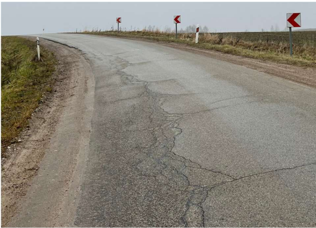
9 pav. Temperatūrinės deformacijos
