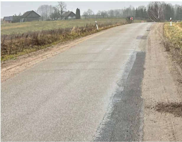
10 pav. Nutrupėję asfalto dangos kraštai
