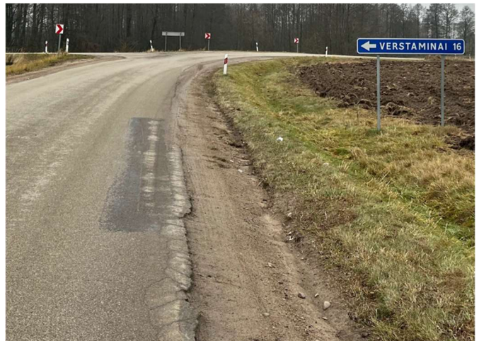
10 pav. Nutrupėję asfalto dangos kraštai
