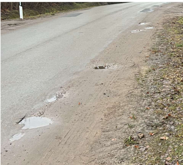
10 pav. Nutrupėję asfalto dangos kraštai
