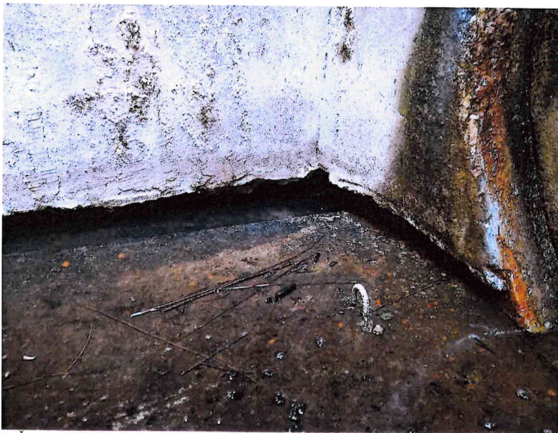
8. Šachtos vidinė siena ties ištekėjimo vamzdžiu.
