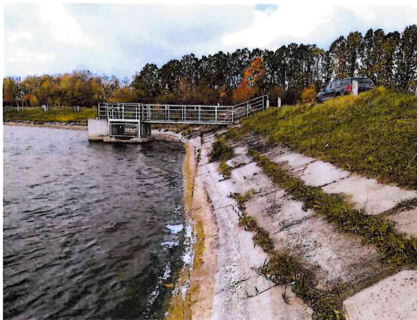
2. Užtvankos aukštutinis šlaitas, šachtos bokštelis, tarnybinis tiltelis.
