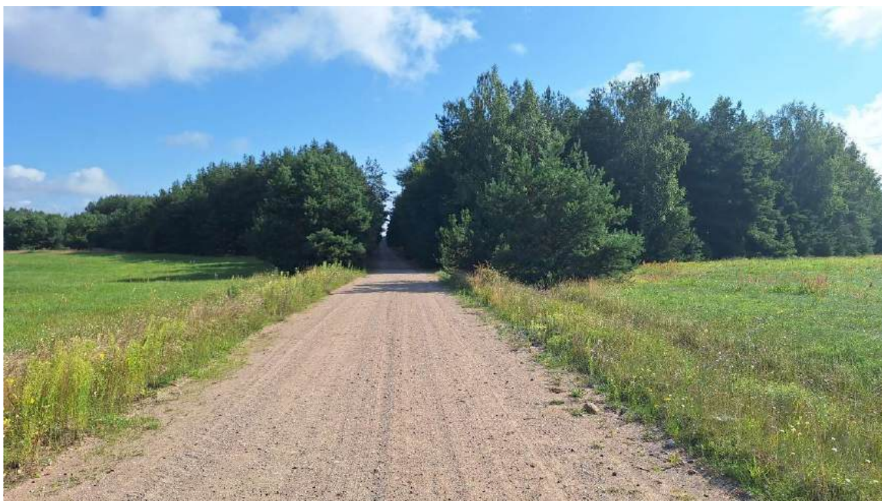
Pav. 12. Dangos būklė vietinės reikšmės kelyje su žvyro danga (apylanka), plotis 5,0 m
