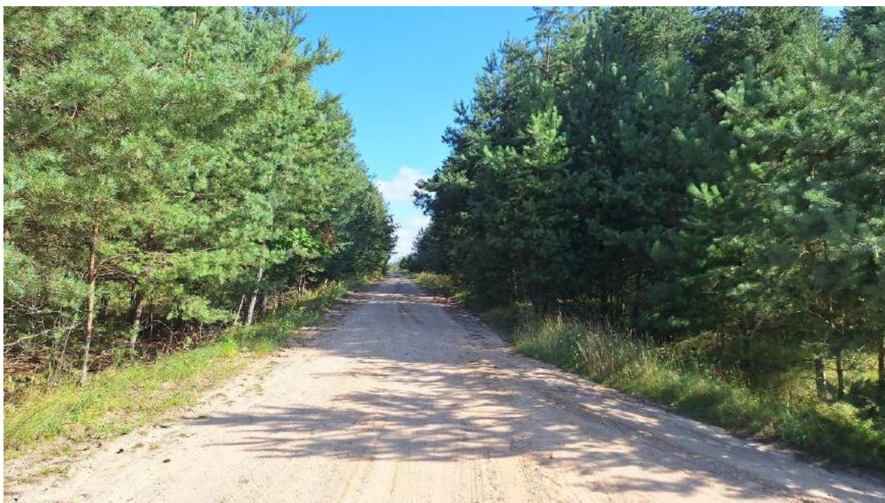
Pav. 16. Dangos būklė vietinės reikšmės kelyje su žvyro danga (apylanka), plotis 5,00 m
