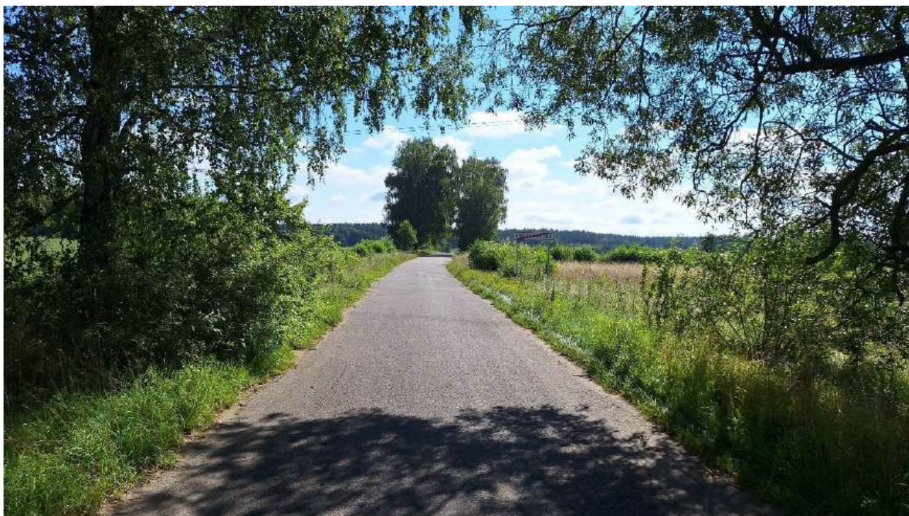
Pav. 19. Dangos būklė vietinės reikšmės kelyje – Pušyno g., su asfalto danga (apylanka), plotis 4,50 m
