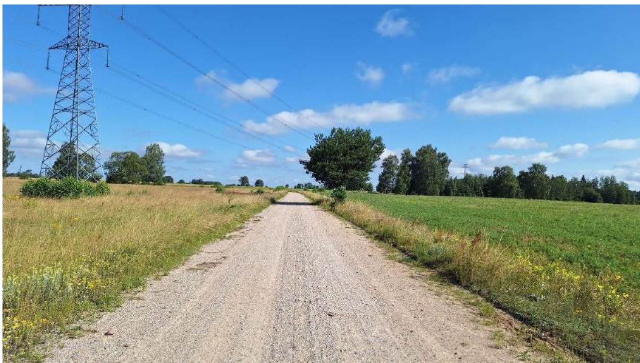
Pav. 18. Dangos būklė vietinės reikšmės kelyje su žvyro danga (apylanka), plotis 5,00 m
