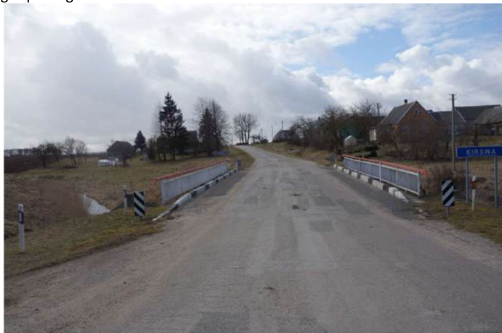
Pav. 9. Kelio dangos būklė
