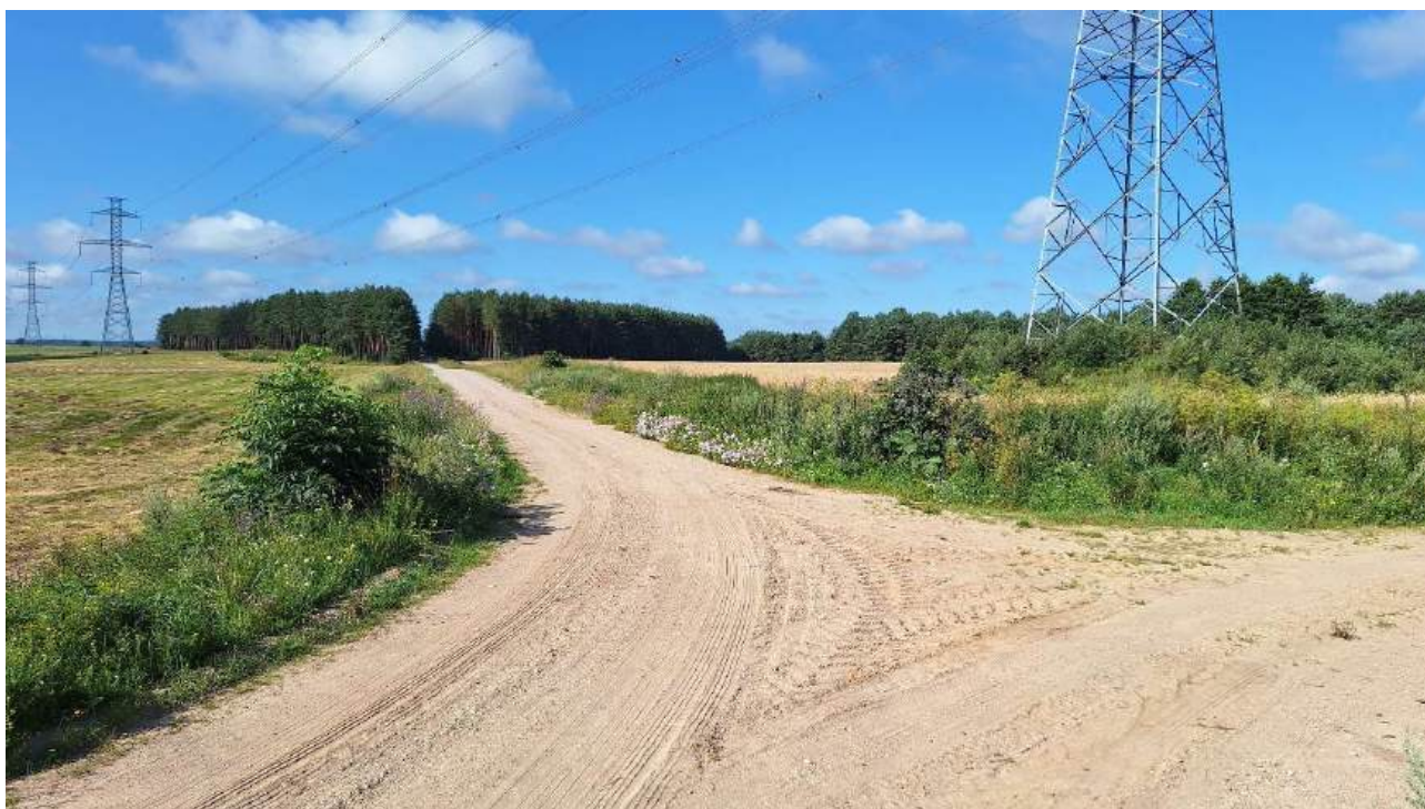
Pav. 14. Dangos būklė vietinės reikšmės kelyje su žvyro danga (apylanka), plotis 5,0 m
