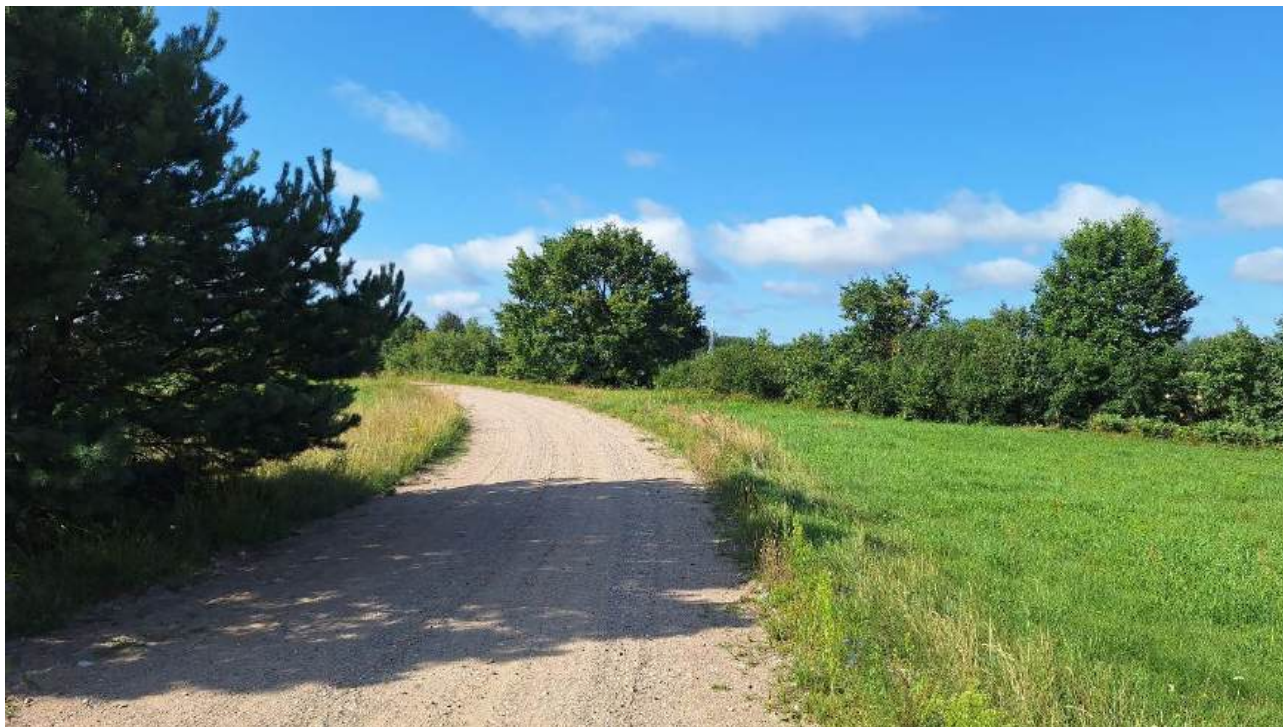
Pav. 11. Dangos būklė vietinės reikšmės kelyje su žvyro danga (apylanka), plotis 4,80 m
