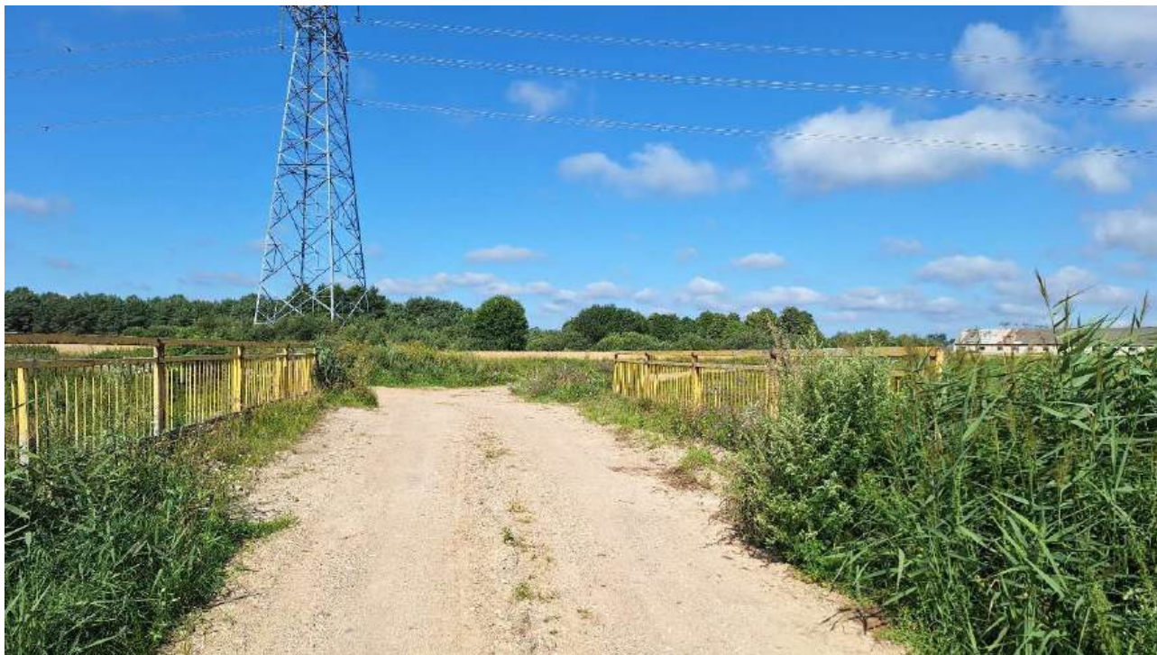
Pav. 15. Dangos būklė vietinės reikšmės kelyje su žvyro danga (apylanka), plotis 5,50 m
