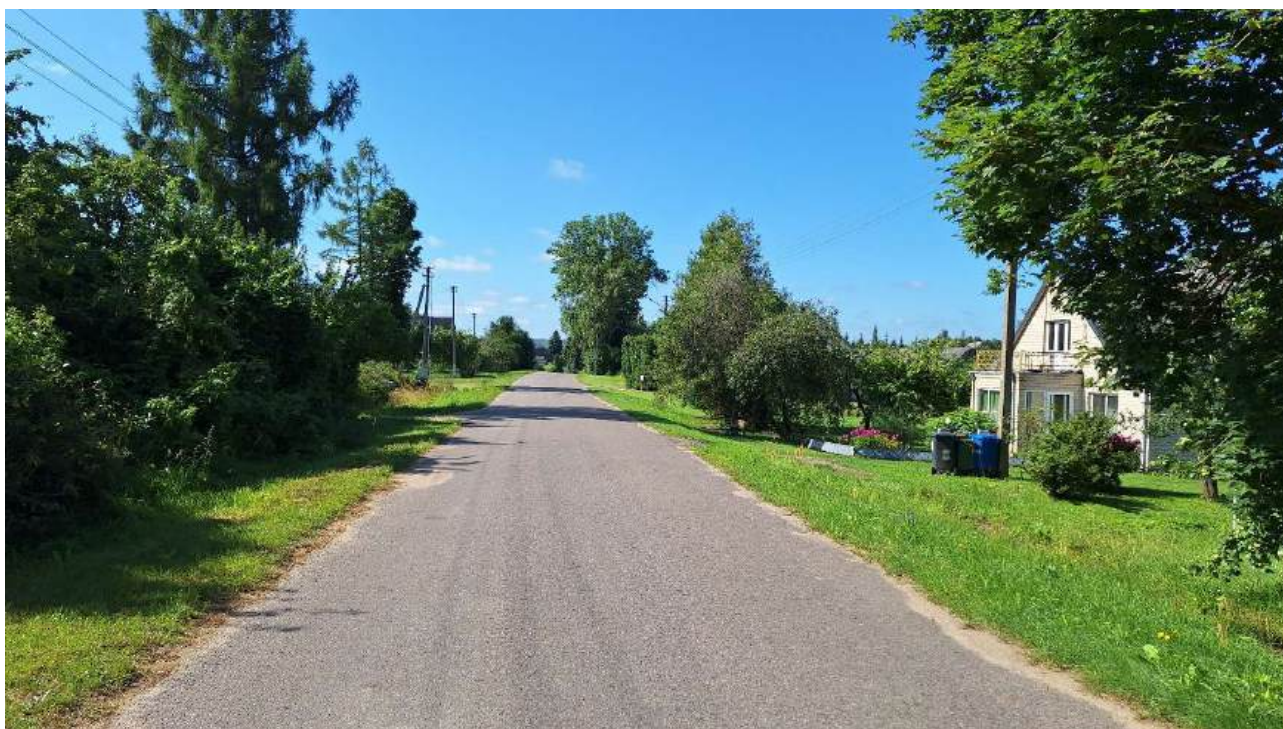
Pav. 20. Dangos būklė valstybinės reikšmės kelyje 2513 apylankoje (Kirsnuokės g.) su asfalto danga, plotis 5,00 m
