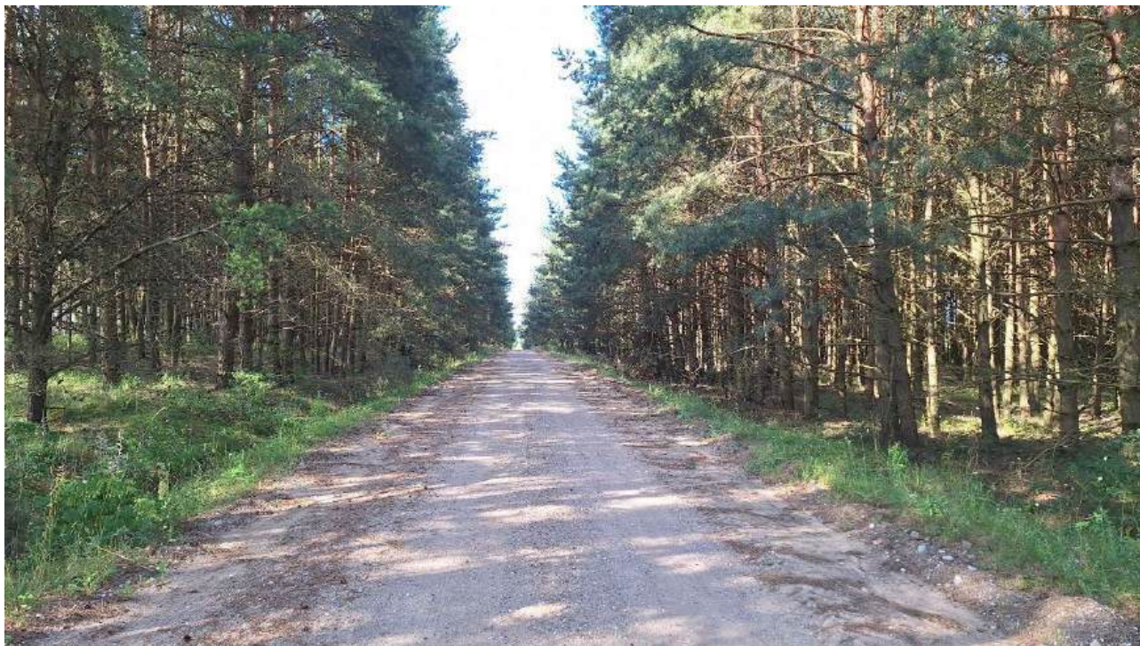
Pav. 13. Dangos būklė vietinės reikšmės kelyje su žvyro danga (apylanka), plotis 5,0 m
