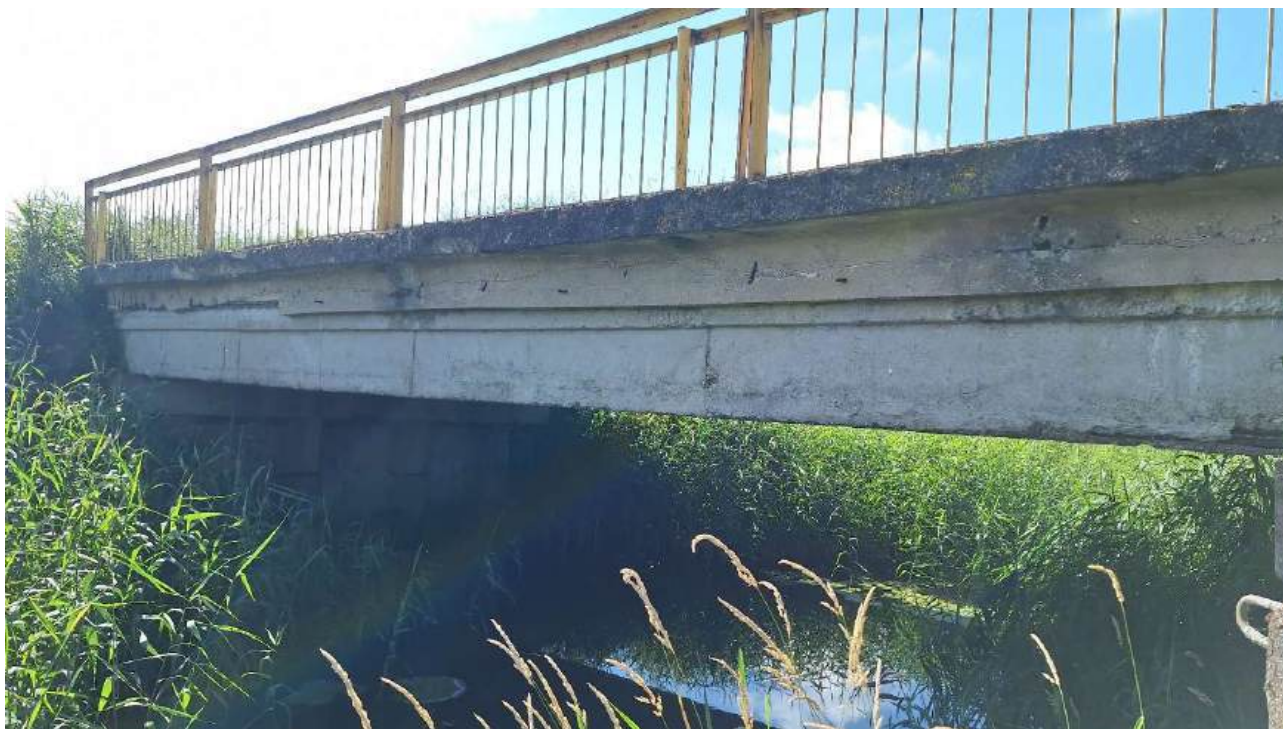
Pav. 21. Tilto per Kirsną apylankoje bendras vaizdas ir nežymūs defektai kraštinėse sijose
